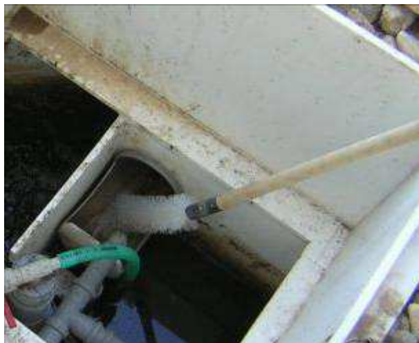
čištění odtokového žlabu
