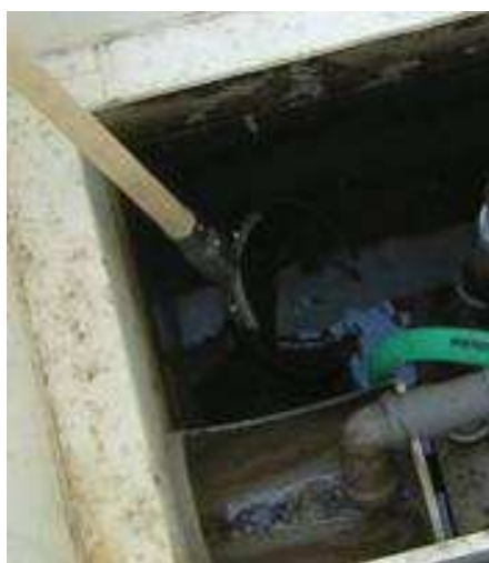
vybrání vyflotovaného kalu z dosazovacího prostoru
